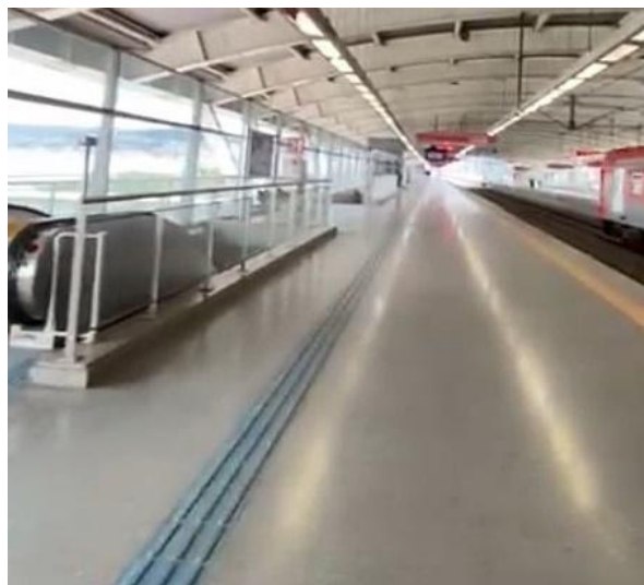
Figura 155 – Rota tátil e sinalização na plataforma
