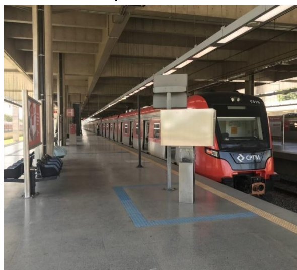
Figura 100 – Rota tátil e sinalização na plataforma
