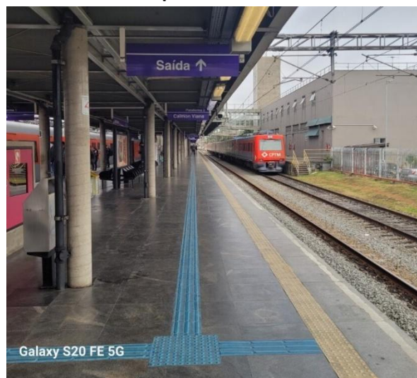
Figura 125 – Rota tátil e sinalização na plataforma
