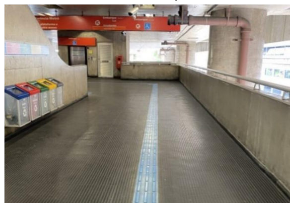
Figura 33 – Rota tátil em direção ao embarque e à transferência para a linha de metrô (3-Vermelha)
